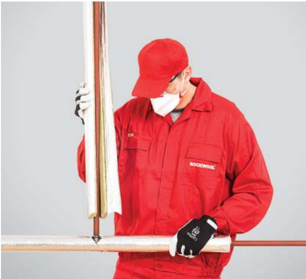
5. Dokładne dopasowanie obu elementów izolacji.
