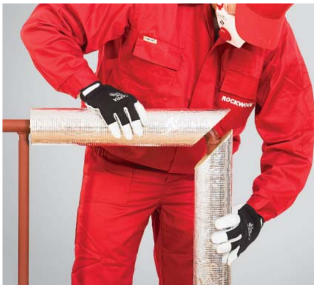
5. Dopasowanie obu elementów izolacji kolana.
