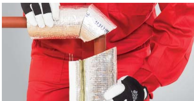
5. Nakładanie odcinka prostego izolacji.
