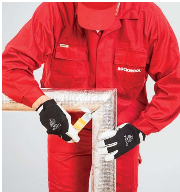
6. Zabezpieczenie połączenia poprzecznego otulin samoprzylepną taśmą aluminiową.
