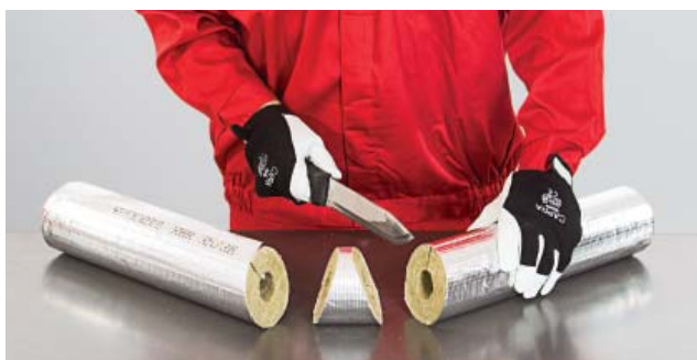
2. Wycinanie segmentu kolanowego – krok II.
