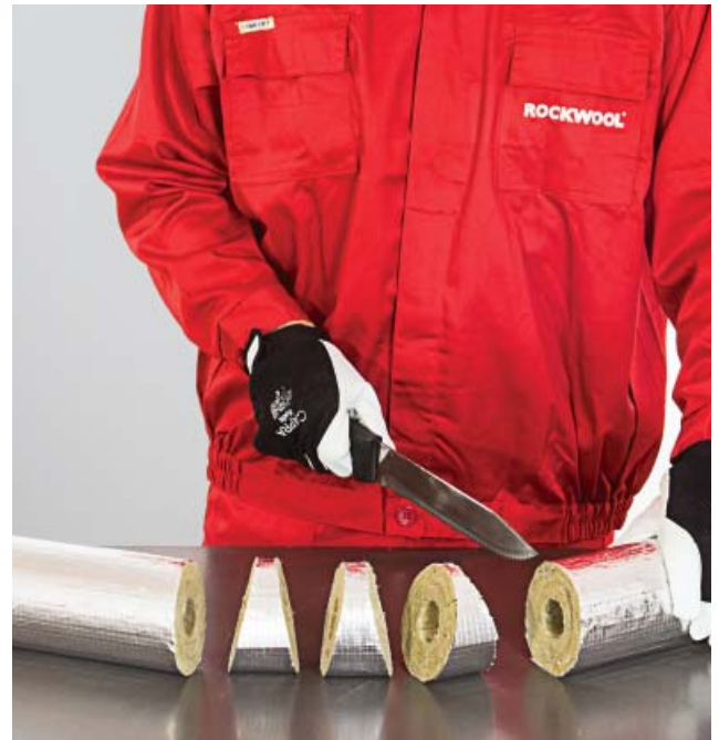
1. Wycinanie segmentów kolanowych.
