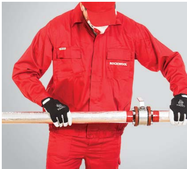
10. Dociśnięcie obu odcinków do niezaizolowanego zaworu.
