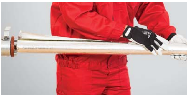
4. Dokładne zaklejenie zakładki samoprzylepnej.
