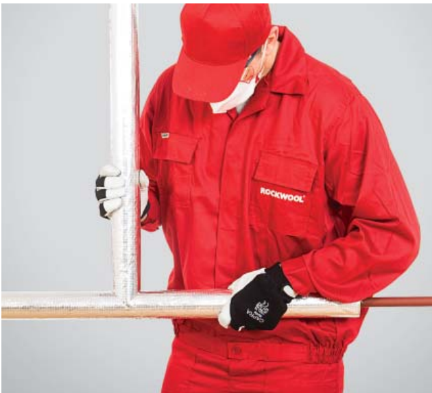
6. Dopasowanie łączonych odcinków.
