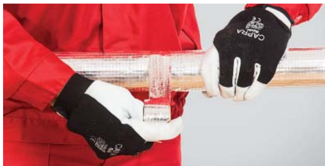
7. Zabezpieczenie połączenia poprzecznego otulin samoprzylepną taśmą aluminiową.
