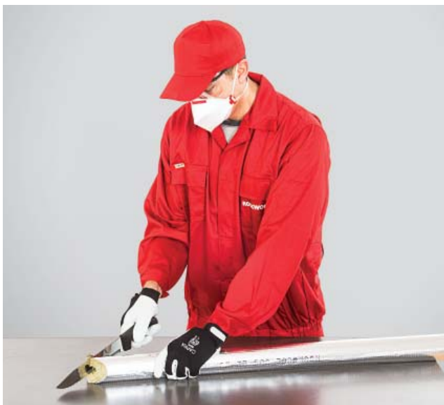
2. Wycięcie klina 2 \times 45^\circ w odcinku izolującym odgałęzienie rurociągu.
