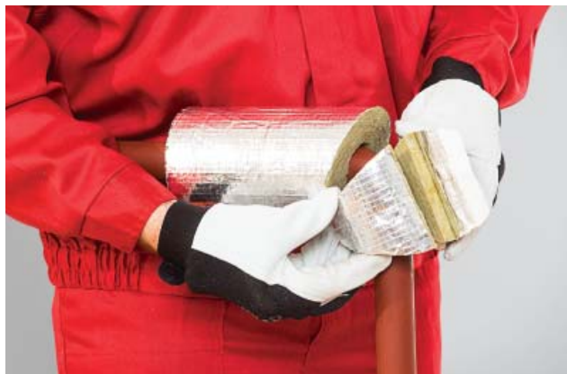
3. Montaż segmentu kolanowego.
