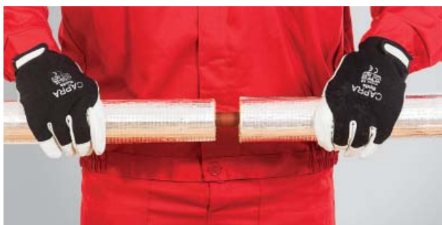
5. Połączenie poprzeczne dwóch odcinków otulin.
