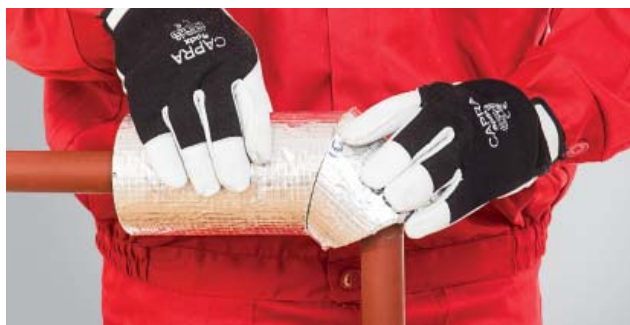
4. Dokładne spasowanie segmentu kolanowego z odcinkiem prostym.
