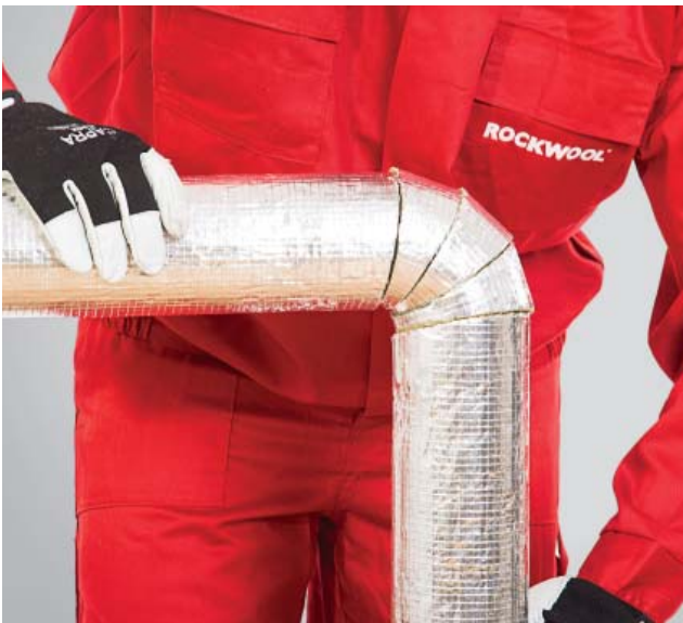
3. Dopasowanie odcinków izolacji do siebie.
