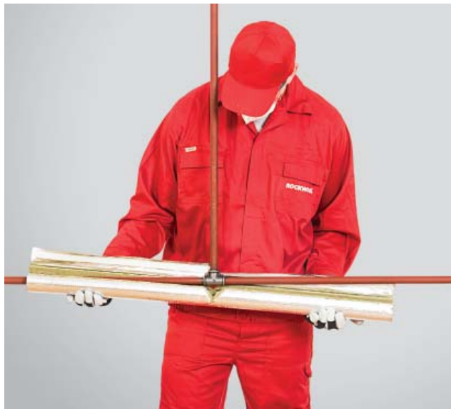
3. Nakładanie izolacji na odcinek rury dochodzący do trójnika.
