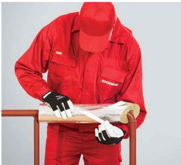
4. Sklejenie połączenia wzdłużnego zakładką samoprzylepną.
