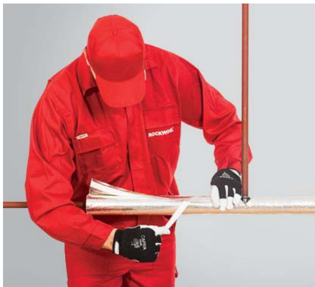
4. Sklejenie połączenia wzdłużnego izolacji zakładką samoprzylepną.
