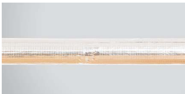
8. Gotowa izolacja składająca się z dwóch odcinków otulin ROCKWOOL 800.
