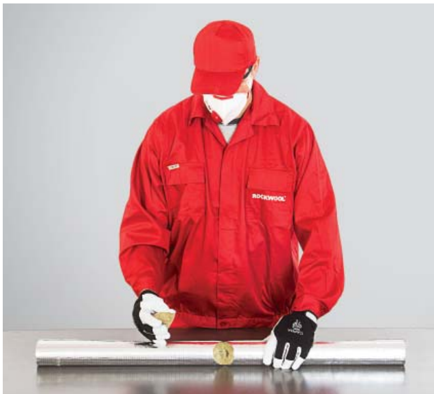
1. Wycięcie klina 2 \times 45^\circ w odcinku prostym, w miejscu trójnika.
