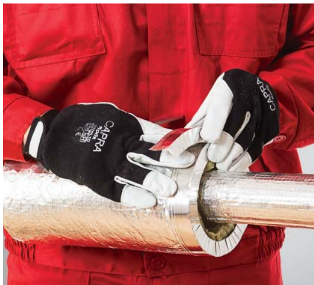
6. Zabezpieczenie zakończenia izolacji mankietem aluminiowym.
