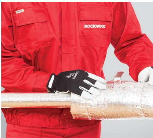
4. Sklejenie miejsca styku maty taśmą aluminiową.
