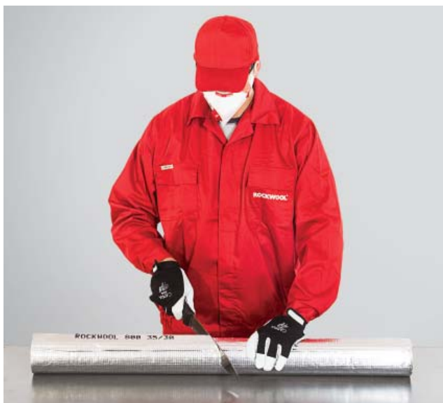
1. Przecięcie otuliny pod odpowiednim kątem.
