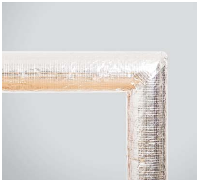
7. Gotowa izolacja kolana z dwóch elementów otuliny ROCKWOOL 800 .
