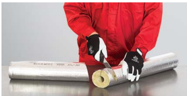
1. Wycinanie segmentu kolanowego – krok I.
