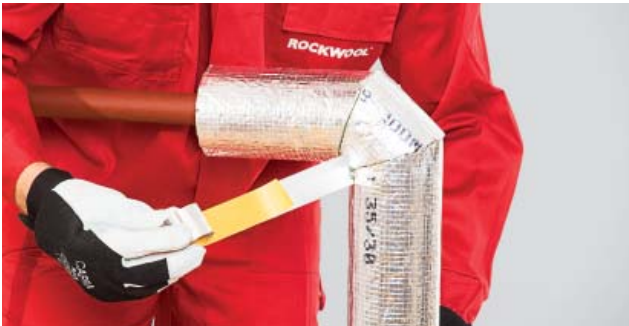
7. Sklejenie połączeń poprzecznych taśmą aluminiową.
