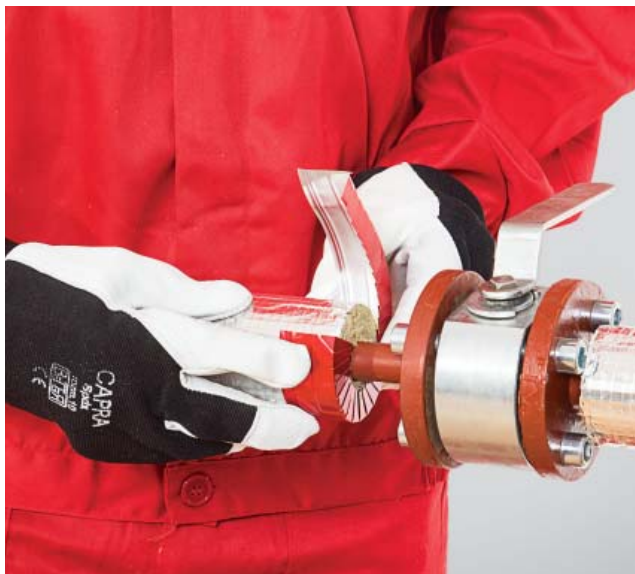
8. Zabezpieczenie zakończenia odcinka prostego izolacji przy zaworze mankietem aluminiowym.
