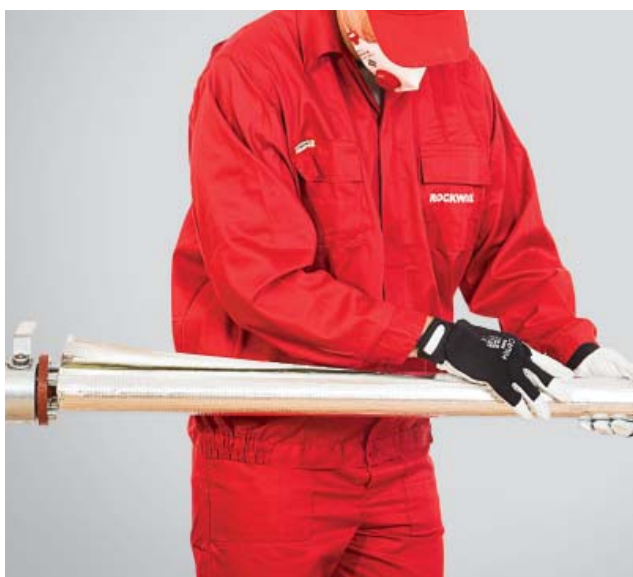
1. Montaż odcinka prostego izolacji.
