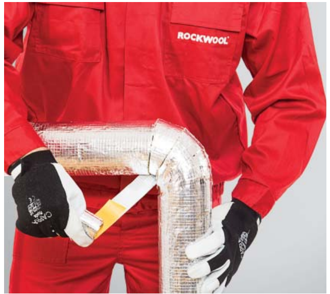
4. Sklejenie połączeń poprzecznych taśmą aluminiową.
