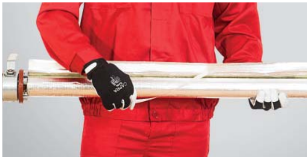
3. Ściągnięcie taśmy PE z zakładki samoprzylepnej.
