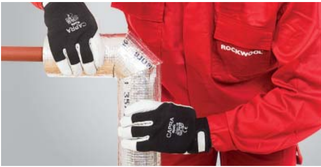
6. Dokładne spasowanie wszystkich elementów.
