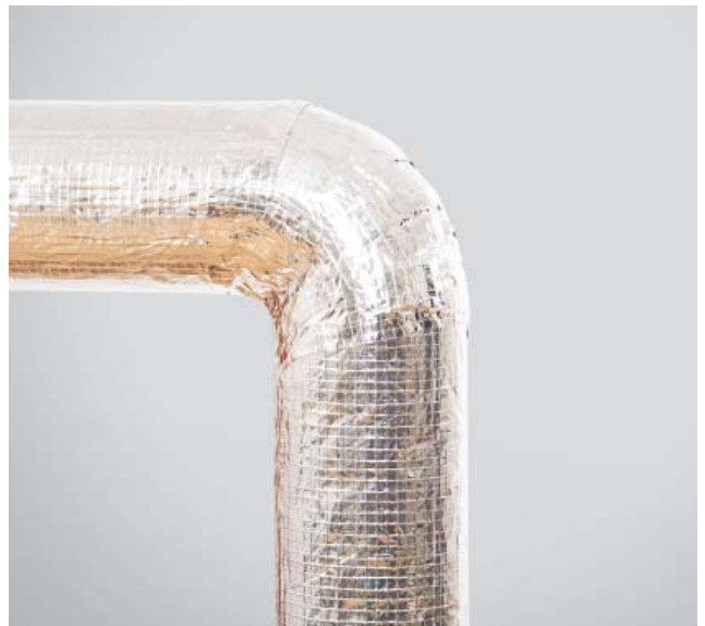
5. Gotowe kolano zaizolowane otuliną ROCKWOOL 800 z jednym segmentem kolanowym.
