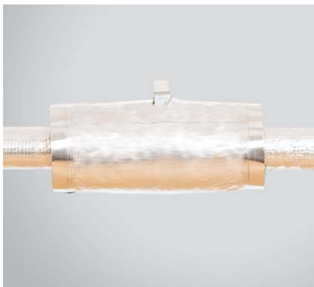
7. Gotowa izolacja zaworu przy użyciu ALU LAMELLA MAT.
