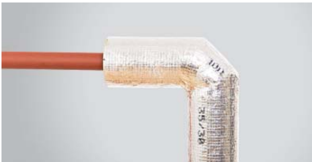
8. Gotowe kolano zaizolowane otuliną ROCKWOOL 800 z jednym segmentem kolanowym.
