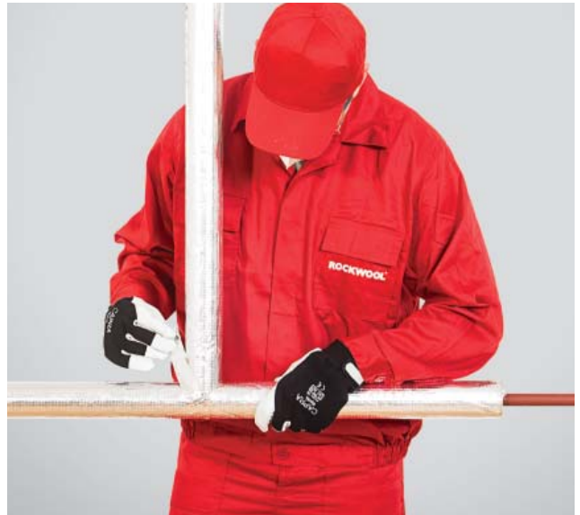
7. Sklejenie styków izolacji taśmą aluminiową.
