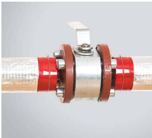
11. Gotowa izolacja rurociągu przy zaworze, gdy nie ma możliwości izolacji zaworu.
