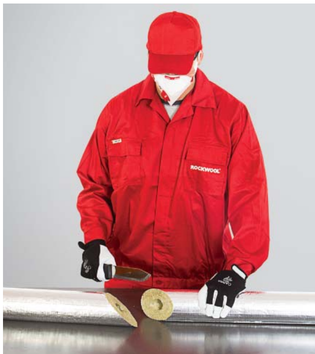
2. Rozcięcie otuliny pod kątem 45^\circ na dwa elementy.
