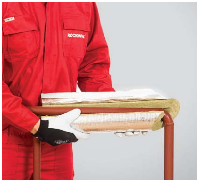
3. Natożenie odcinka izolacji na rurociąg.
