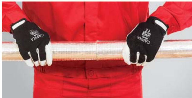
6. Dopasowanie poszczególnych odcinków otuliny.
