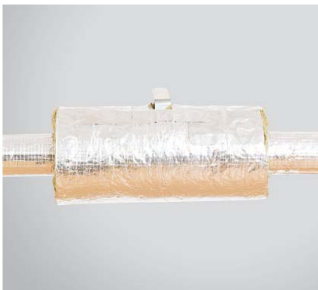
5. Zawór zabezpieczony matą ALU LAMELLA MAT.
