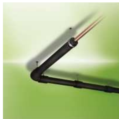
Brak bezpośredniego styku pomiędzy rurą a obejmą jest jednym z warunków optymalnego działania instalacji, fot. Armacell
