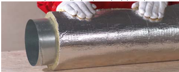
Owiniecie kanału izolacją.
