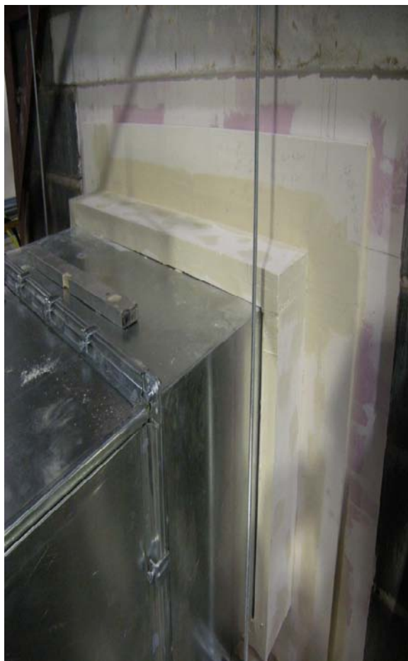
Kołnierz z kątownika 200 x 200 mm
