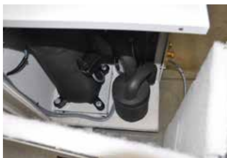
Materiały akustyczne K-FONIK GK i K-FONIK FIBER P w obudowie pompy ciepła
