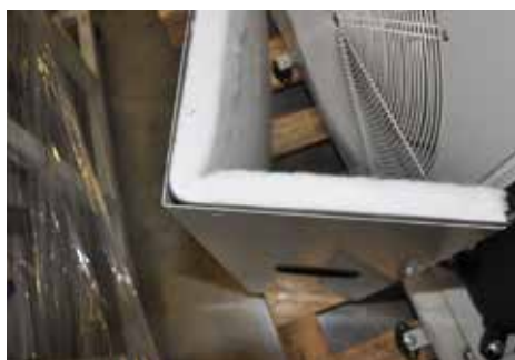
Materiały akustyczne K-FONIK GK i K-FONIK FIBER P w obudowie pompy ciepła
