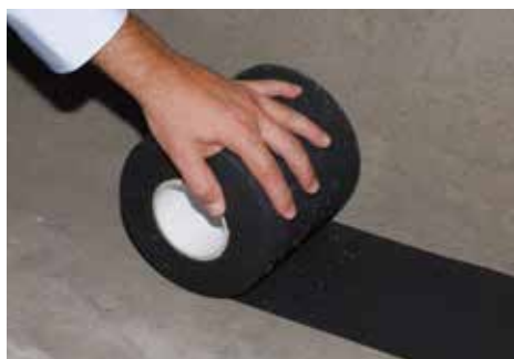
Rozwijanie i montaż pasa dylatacyjnego K-FONIK GK
