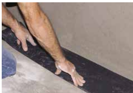
Rozwijanie i montaż pasa dylatacyjnego K-FONIK GK
